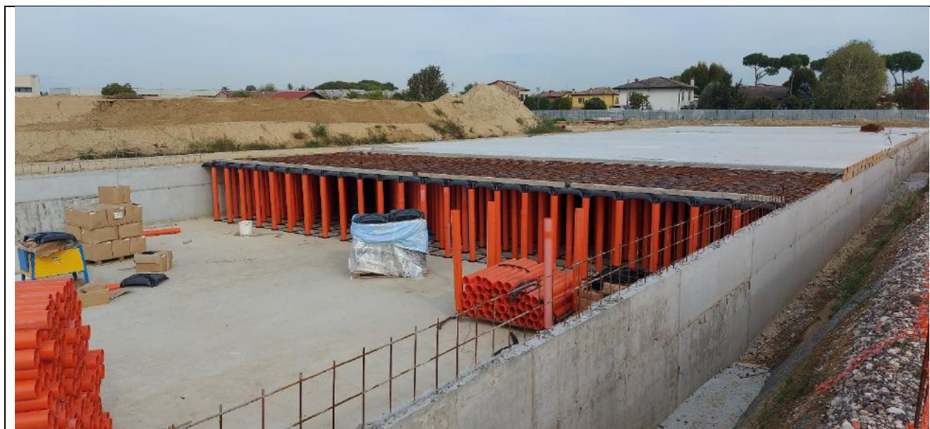
Fig. 92 – Vasca dimensioni 150 m x 27 m x H 1,4 metri – Volume utile pari a 4.800 mc (area industriale di Cadoneghe - Padova)
