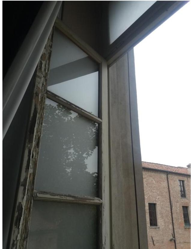
Invece, per le finestre relative alla Sala di Consiglio (ex Chiesa Nuova e Cappella di Corte), essendo quelle originali montate nel secondo dopoguerra a seguito dell' intervento dell'ing. Carlo Savonuzzi, si prevede una pulizia, un restauro delle parti deteriorate ed una eventuale riverniciatura, nel rispetto del *manufatto* originale.
