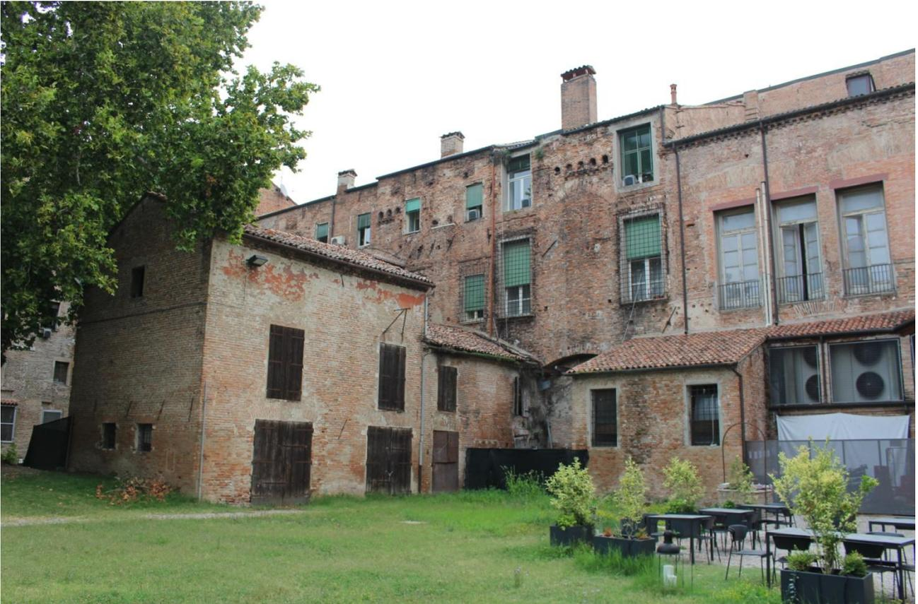
Gli interventi previsti per questi fabbricati sono, oltre al consolidamento strutturale, alla luce anche delle nuove aperture previste, il rifacimento delle coperture, il restauro e consolidamento delle murature seguendo le linee guida e i metodi usati per il prospetto retrostante dell'ala est del palazzo.
